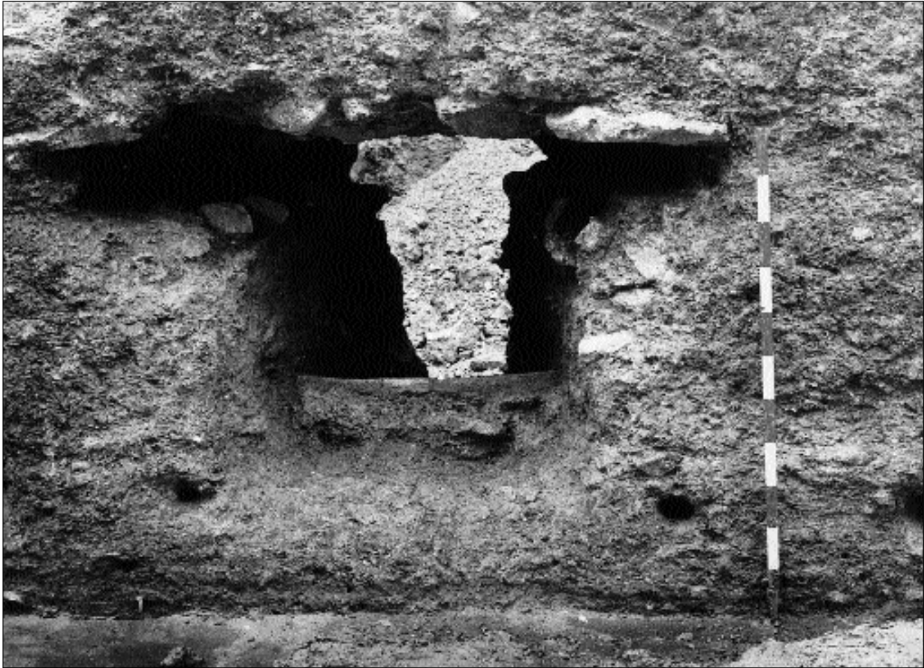
Detalle de una de las saeteras cuyo umbral fue sobreelevado y repavimentado con ladrillos en época mudéjar.
