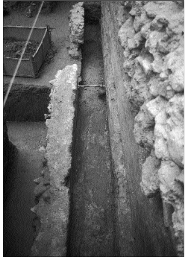
Sector intramuros, atarjea que discurre paralela a la muralla. La pared interior del vaso es la propia muralla.
