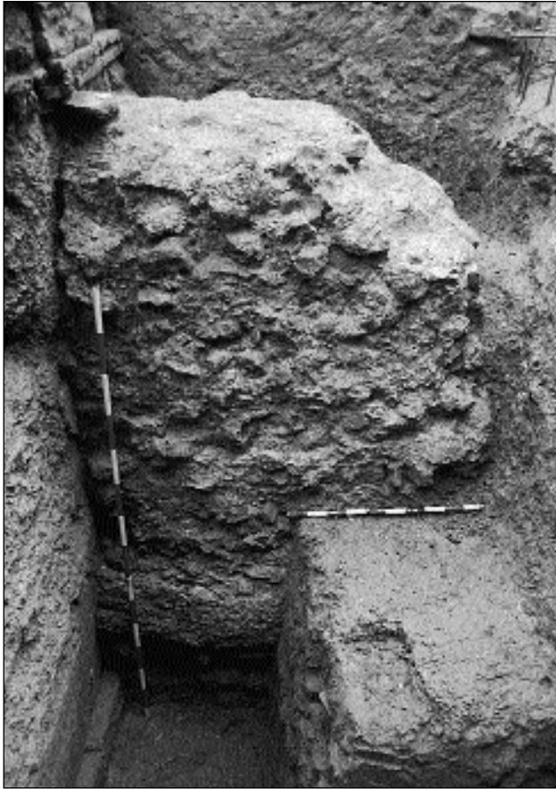
Costado oriental de la torre 2. Se aprecia la cimentación volada y cómo la estructura apoya en la muralla.
