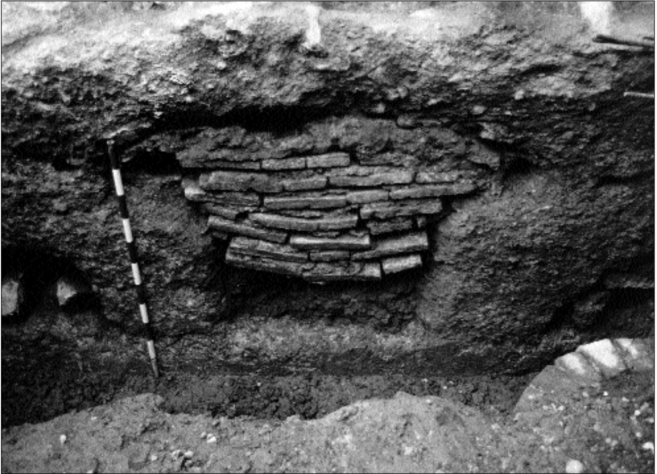
Detalle de una de las saeteras cegadas cuando se construye el Alcázar de Enrique III y se sobreeleva el suelo de la barbacana.
