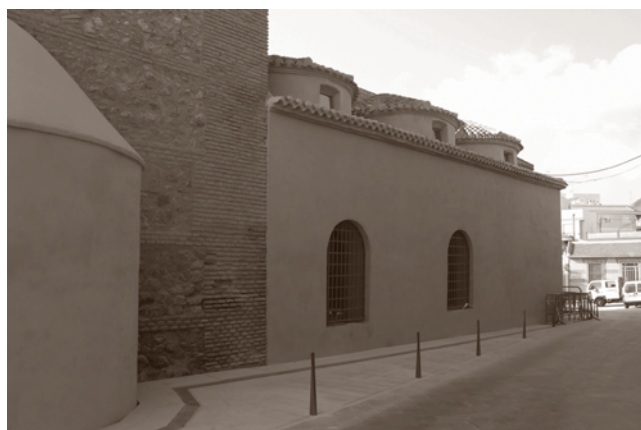
FACHADA NORTE POSTERIOR A LA INTERVENCIÓN
