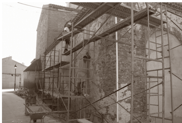
FACHADA NORTE DURANTE LA INTERVENCIÓN
