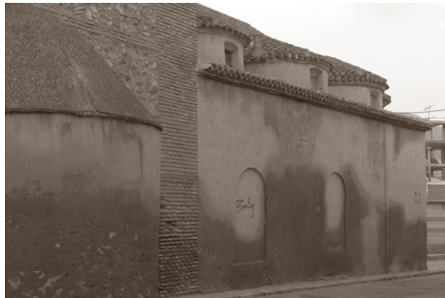
FACHADA NORTE ANTERIOR A LA INTERVENCIÓN
