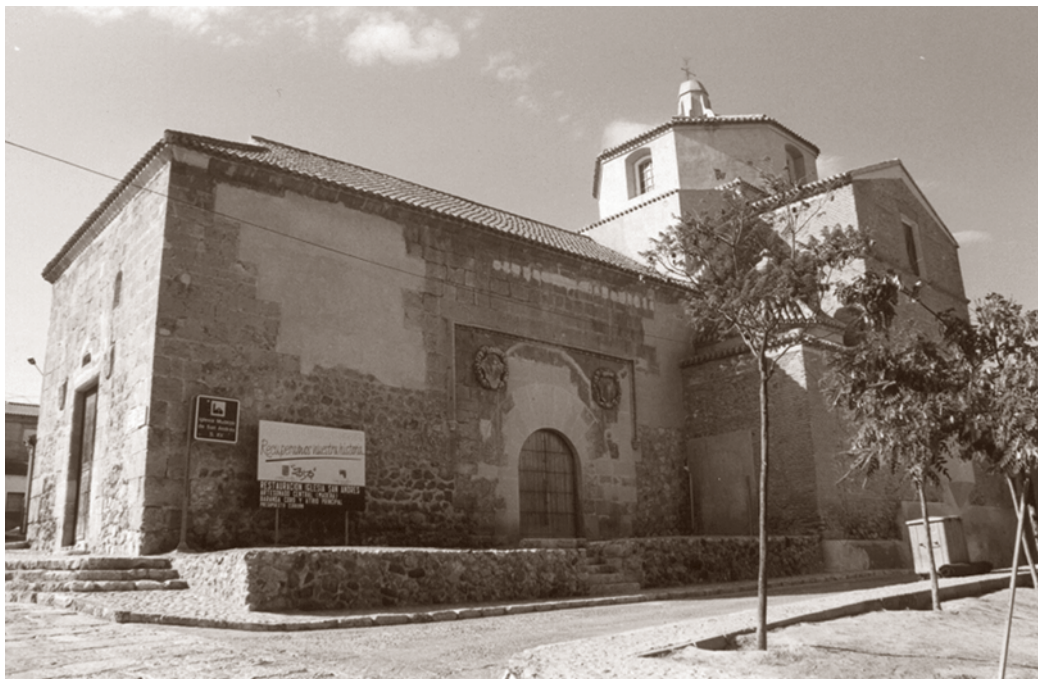
EXTERIOR DE LA IGLESIA DE SAN ANDRÉS
