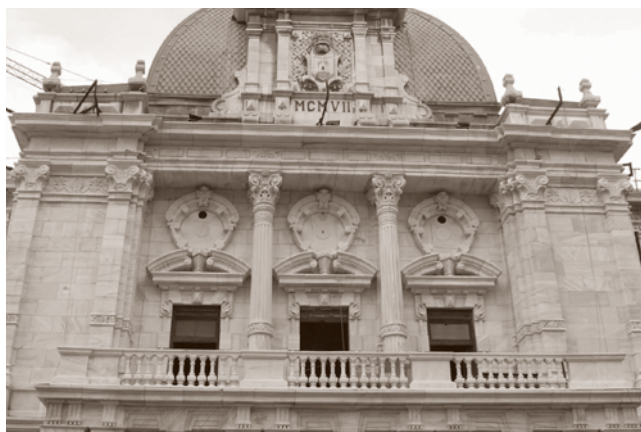
FACHADA PRINCIPAL. DURANTE LA INTERVENCIÓN.
