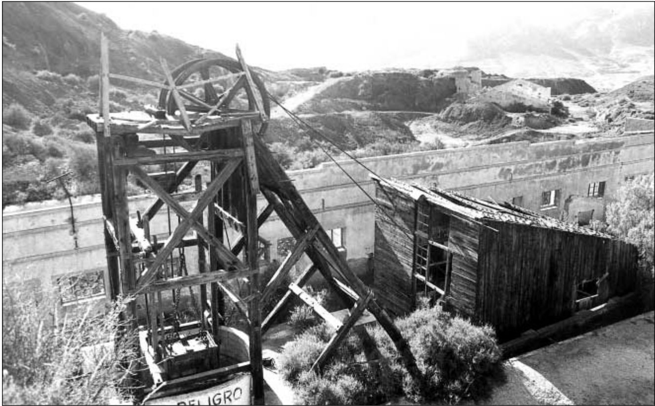
Foto 6.- Castillete de madera de pino Canadá de la mina San Simón y Sala de máquinas de vapor. Conjunto Ledua.
