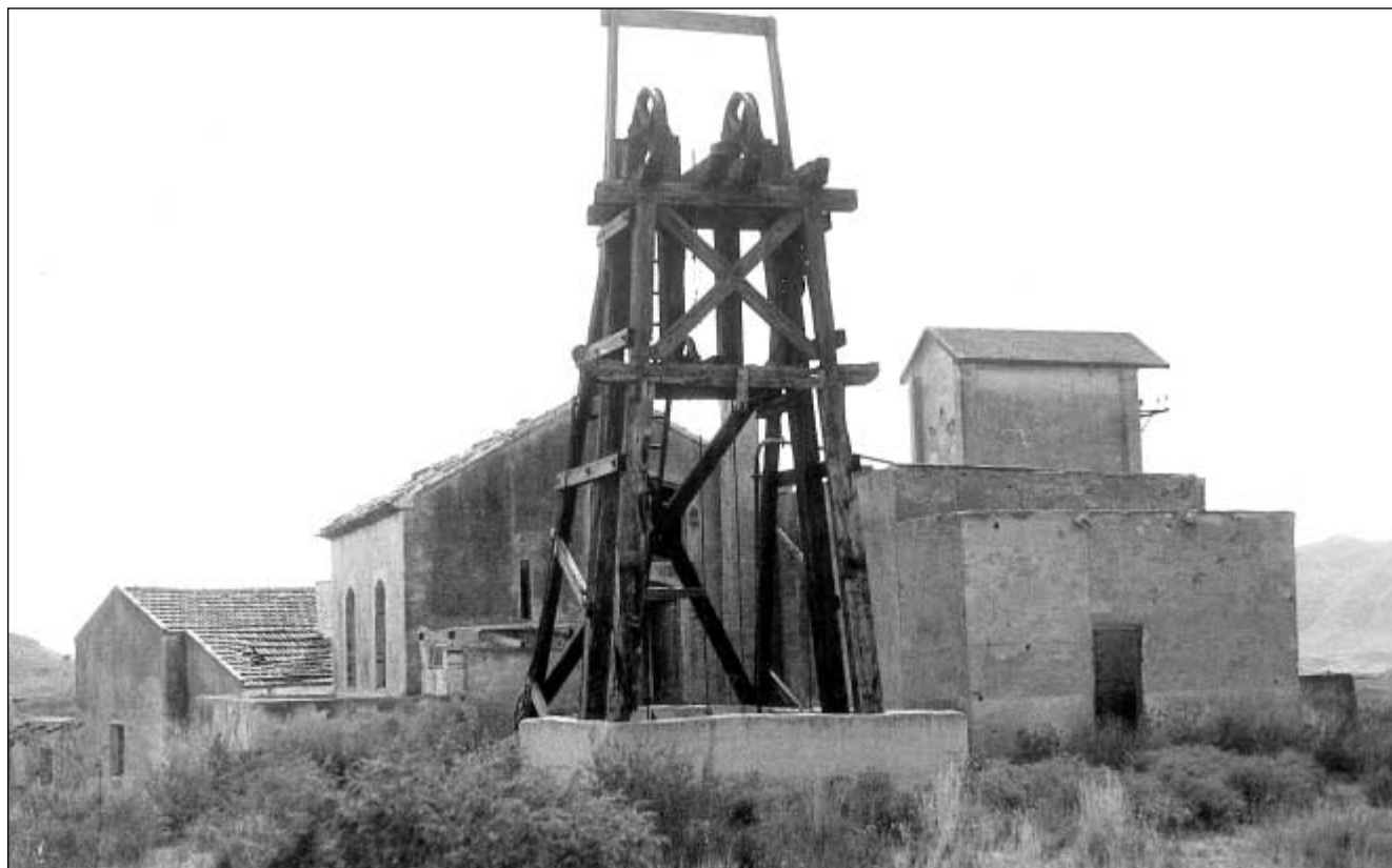
Foto 12.- Castillete de madera de la mina Luisito.
