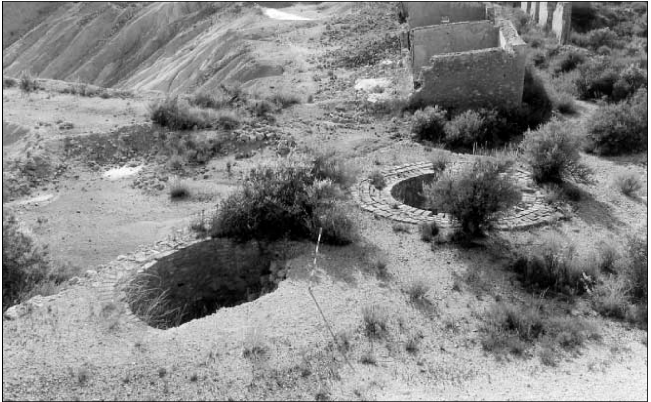
Foto 4.- Hornos de calcinación de alunita para producción de alumbre y almagra. Conjunto Vistalegre.
