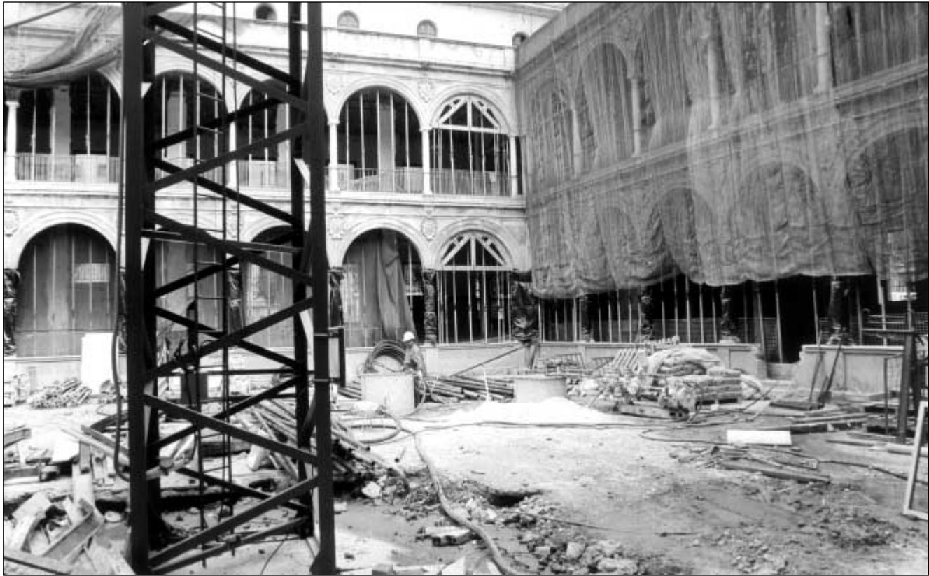
Foto 1. Vista interior del Claustro de La Merced.
