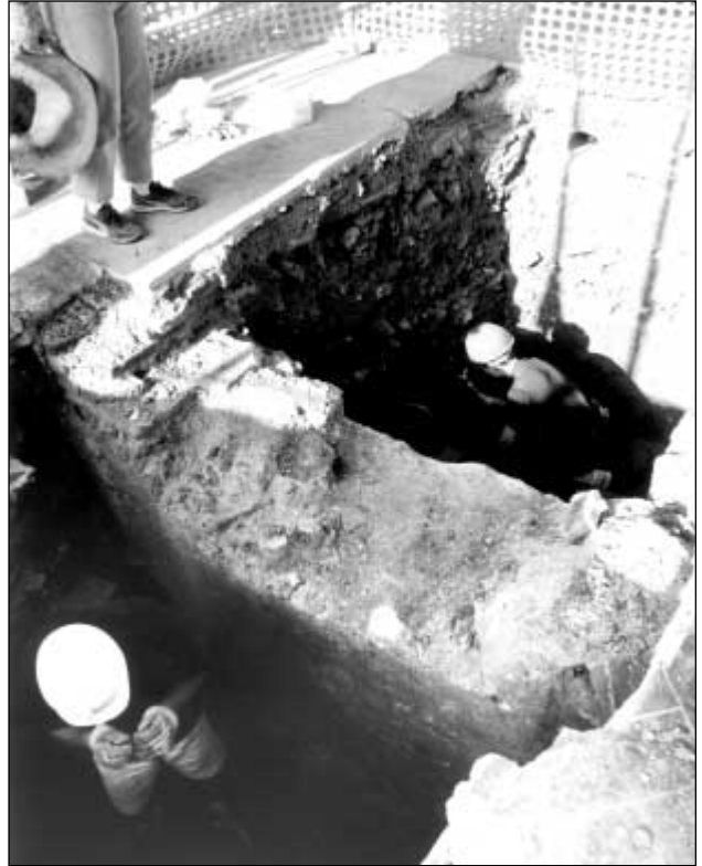
Foto 4. Cata 1: lateral W del Claustro. Proceso de excavación.
