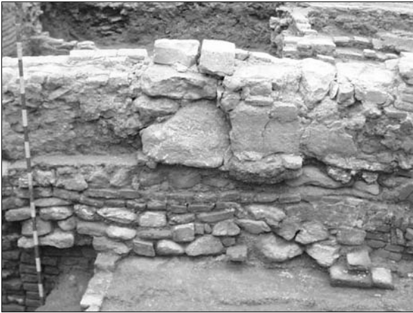
Lámina 20. Edificio A, Fase 3b. Muro de mampostería y verdugadas de ladrillo de la cruzía norte.
