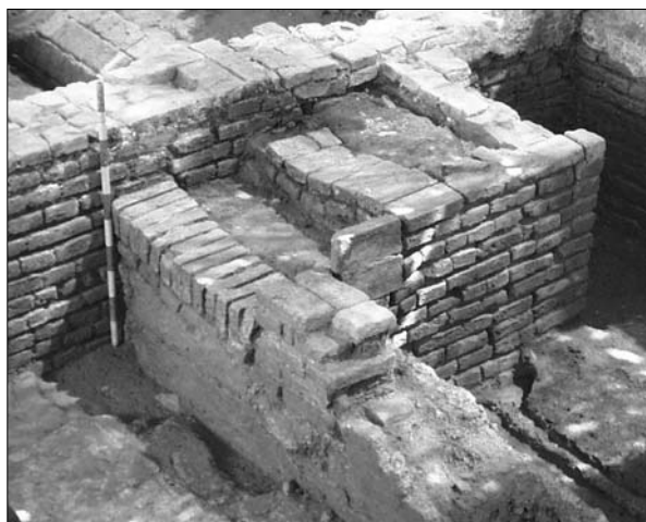
Lámina 9. Casa A, Fase 4, primer momento. Escalera.
